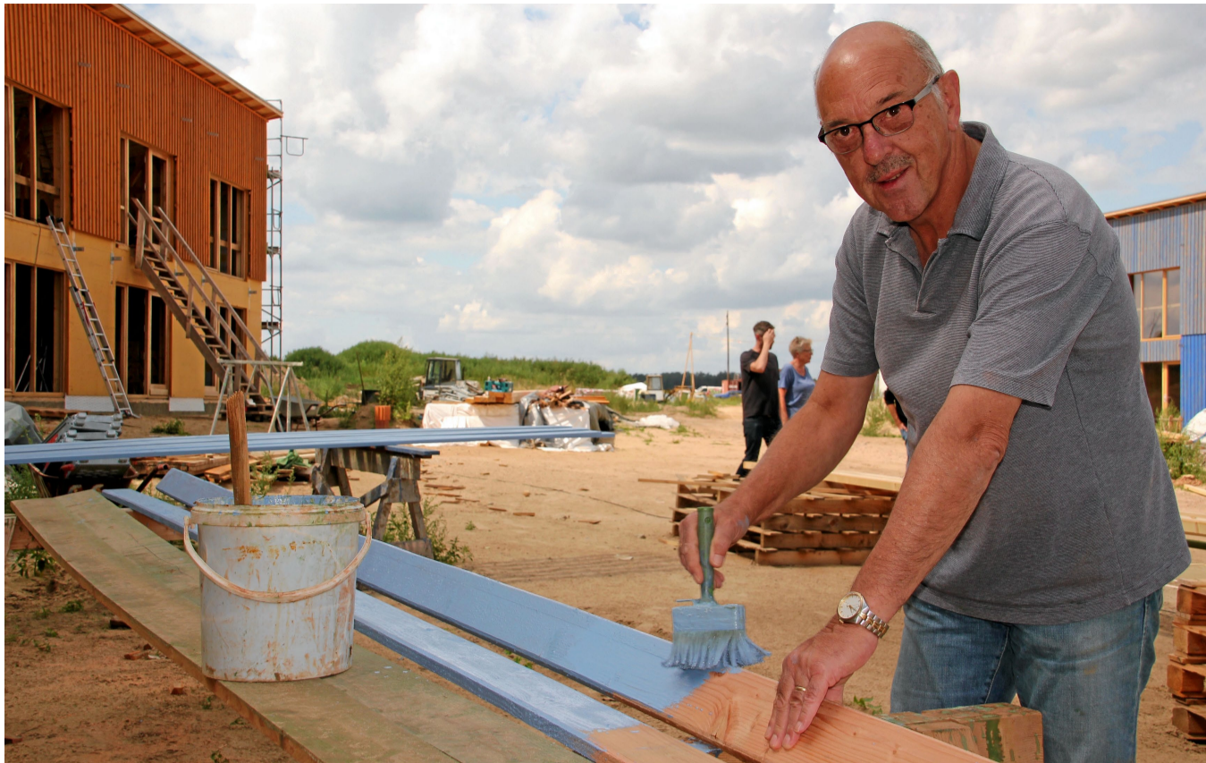
Ob mit Maurerkelle, Wasserwaage oder Pinsel: Landessuperintendent Dieter Rathing packt im Hitzacker-Dorf mit an.
